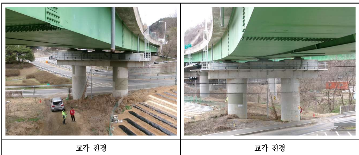
【사진 1.3.11】 교각 전경
