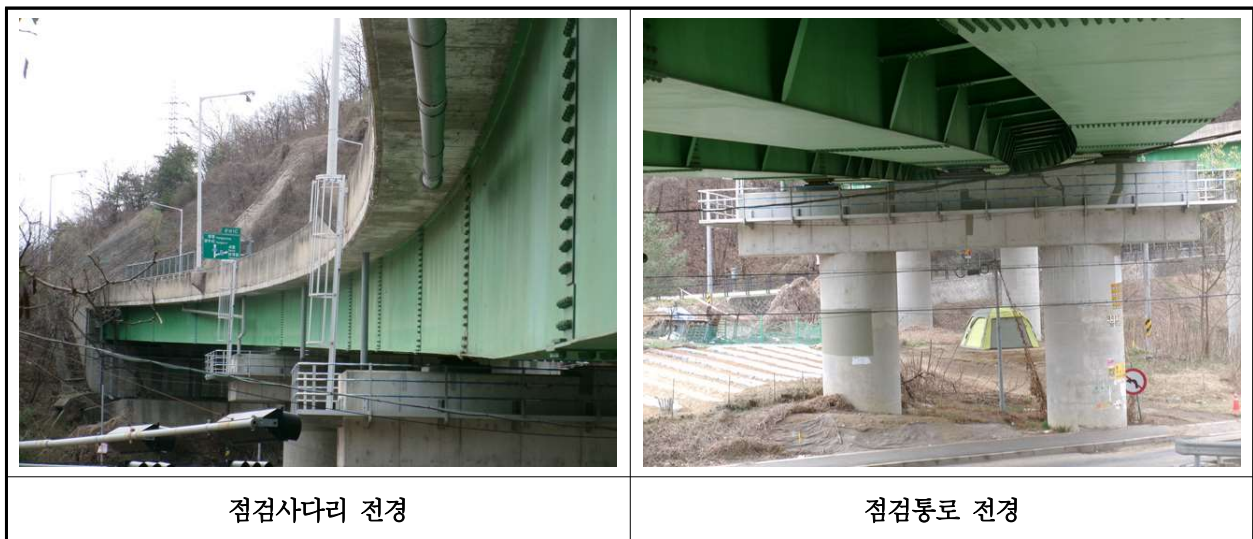
【사진 1.3.23】 교량 점검시설 전경
