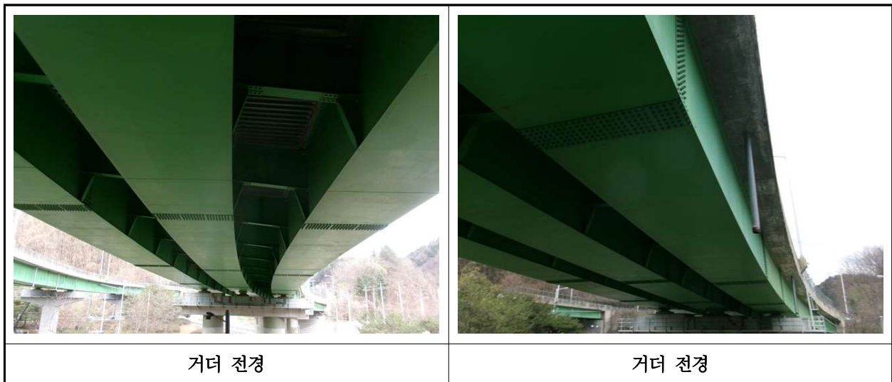
【사진 1.3.4】 거더 전경
