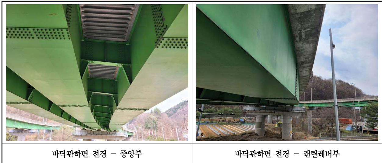
【사진 1.3.2】 바닥판하면 전경
