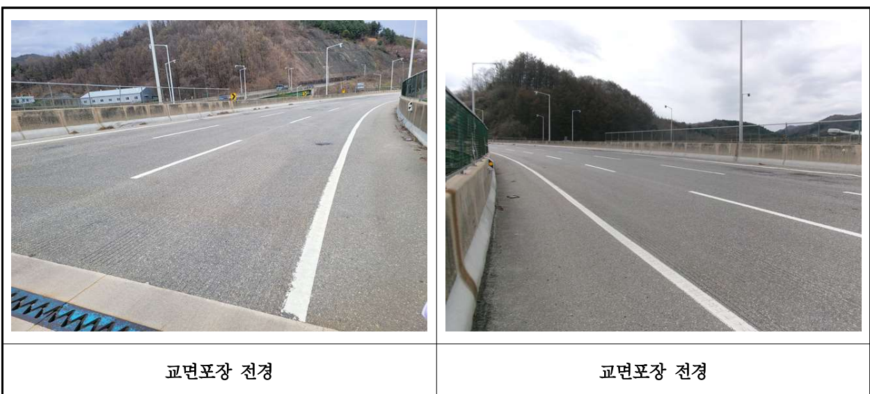
【사진 1.3.17】 교면포장 전경
