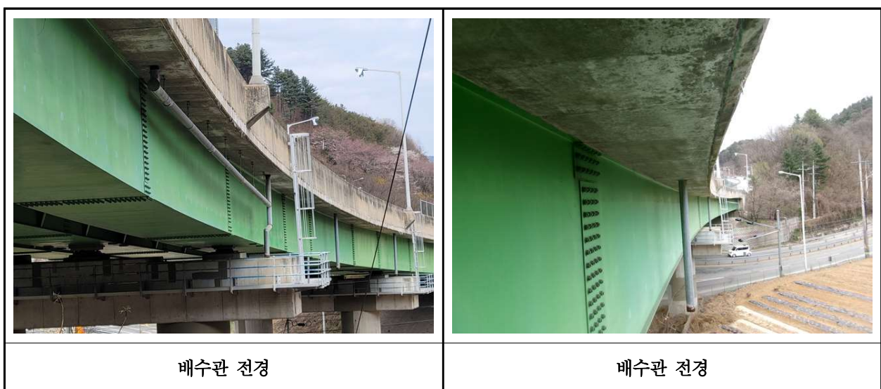
【사진 1.3.19】 배수시설 전경
